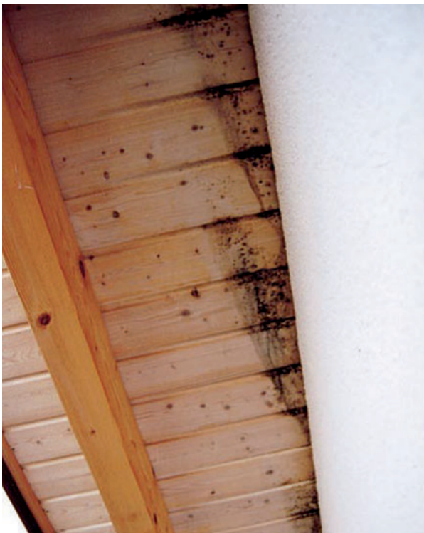
Bild 9: Dachüberstand außen an der Dachwohnung
