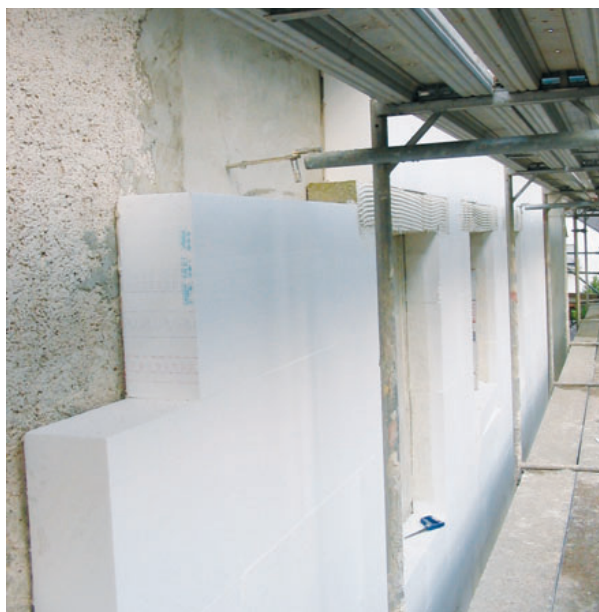
Bild 29: Wärmedämmverbundsystem mit Polystyrol
