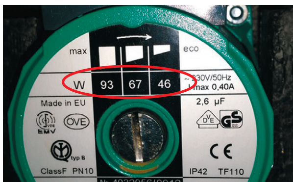
3-stufige Heizungspumpe (Regelung manuell) mit einer Leistungsaufnahme zwischen 46-93 Watt
