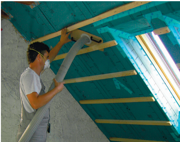
Der Dämmstoff wird eingeblasen.
