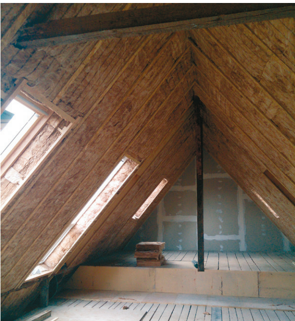
Zwischensparrendämmung mit Steinwolle
