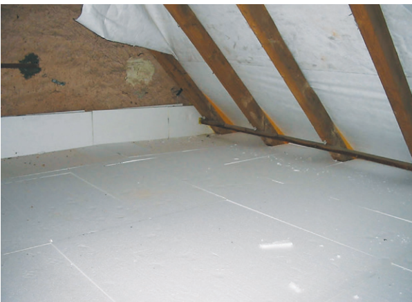
Dachbodendämmung mit Flankendämmung an der Giebelwand.
