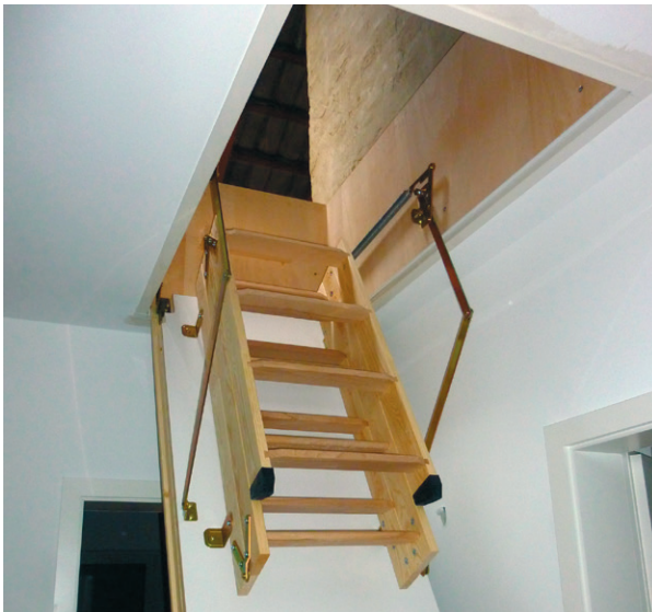
Eine neue, gedämmte Bodentreppe.
