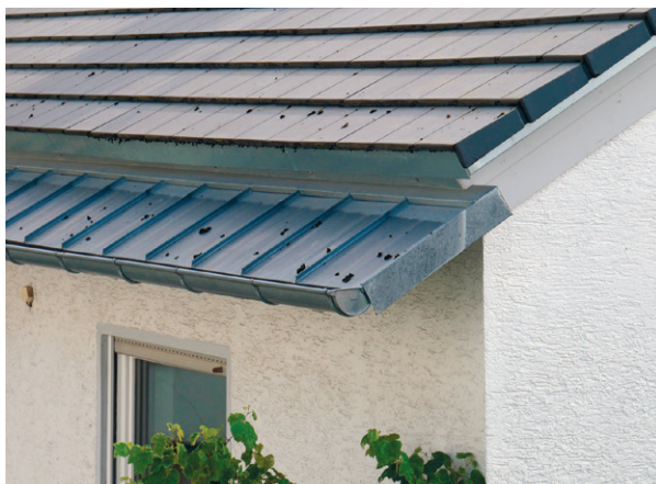
Ein neuer Dachüberstand aus Zinkblech.
