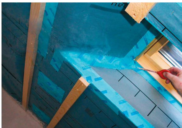
Die Dichtheit wird überprüft.
