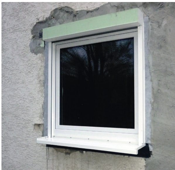
Fenster mit außenliegendem Rollladenkasten für gleichzeitige Fassadendämmung
