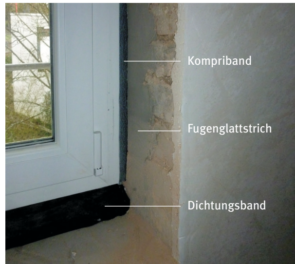
Gut vorbereitete Leibung für rundum dichte Anschlüsse
