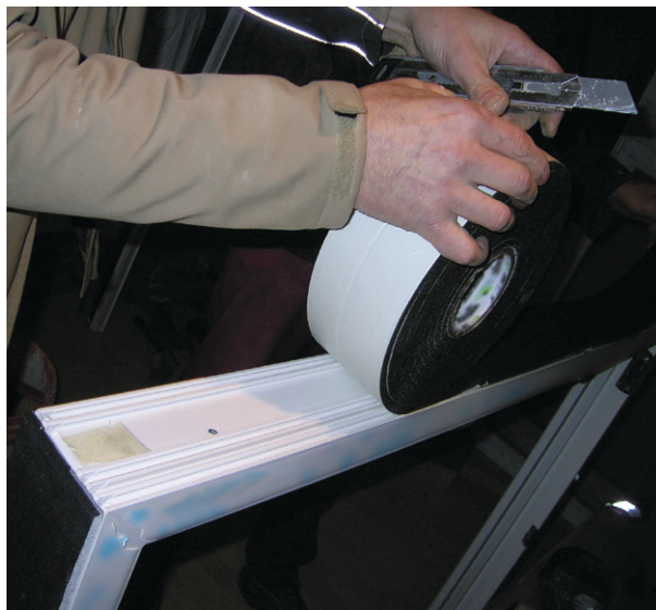
Einbau eines Multifunktionsdichtungsbandes
