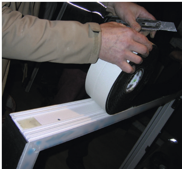
Einbau eines Multifunktionsdichtungsbandes
