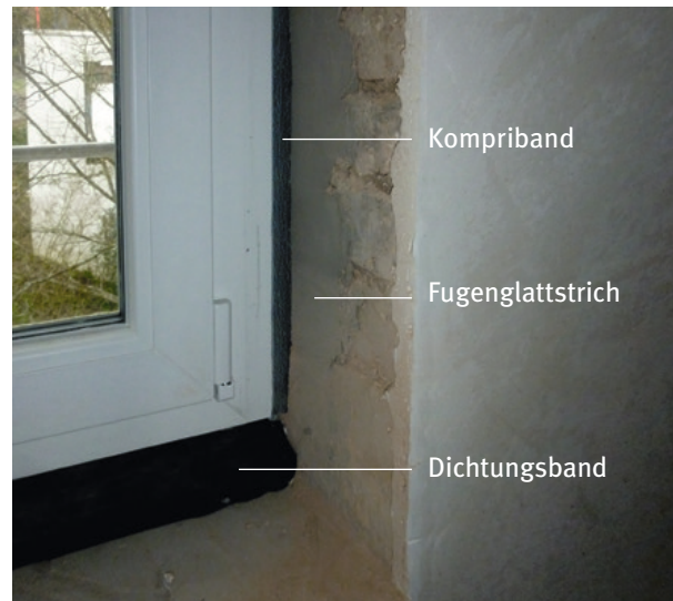
Gut vorbereitete Leibung für rundum dichte Anschlüsse
