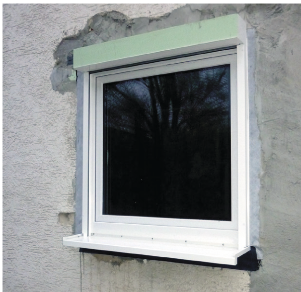
Fenster mit außenliegendem Rollladenkasten für gleichzeitige Fassadendämmung
