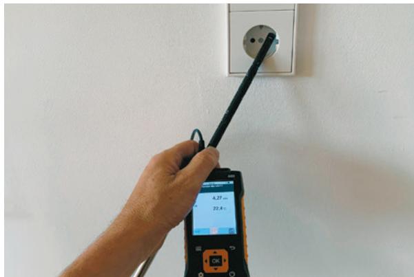
Mit dem Thermo-Anemometer wird hier an einer Steckdose eine Luftströmung festgestellt.
