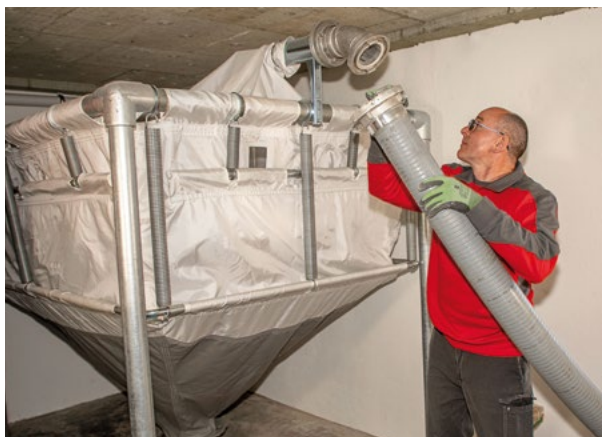
Das Sacksilo wird über einen Schlauch mit Pellets befüllt.
